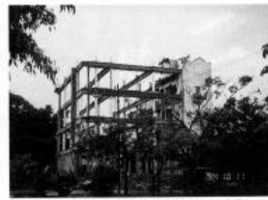
1972年の大地震で、フレームだけになった建物の1つ。モニュメント的にあちこちに残されている
